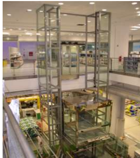
Hidravlično panoramsko dvigalo z centralnim batom
